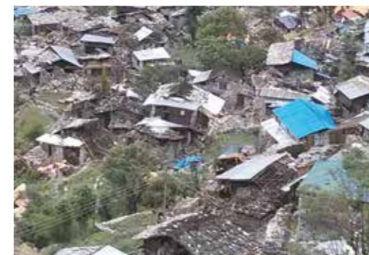
Besonders in den abgelegenen Bergdörfern Nepals beklagen die Menschen viele Opfer und massive Schäden an Hausbauten. Foto: International Nepal Fellowship (INF)
