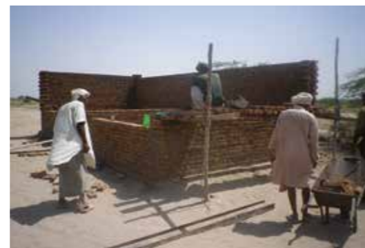
Bei allen Bauarbeiten sind die Familien als Bauhelfer beteiligt. Foto: CLARA
